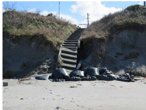
浜が削られて階段が壊れている
